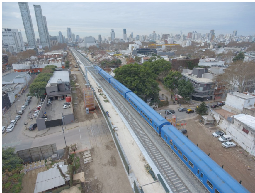
Imagen 4. Viaducto San Martín entre Villa Crespo y Palermo.
