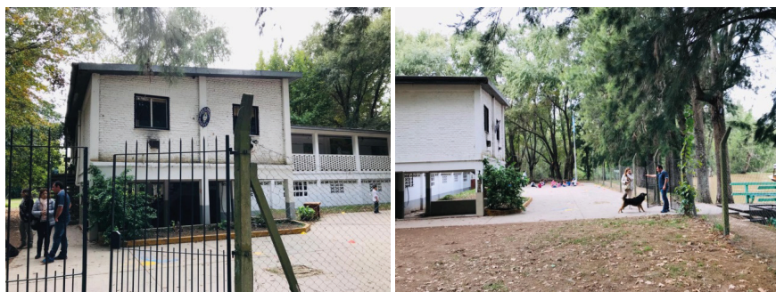
Foto 1: Escuela N.º 13 Julián Anguiano. Islas del Tigre. Frente del edificio. Fuente: Elaboración propia.
